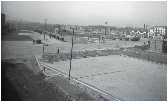
Le parvis de la gare en mars 1927, avant la construction du passage supérieur. Photographie.
