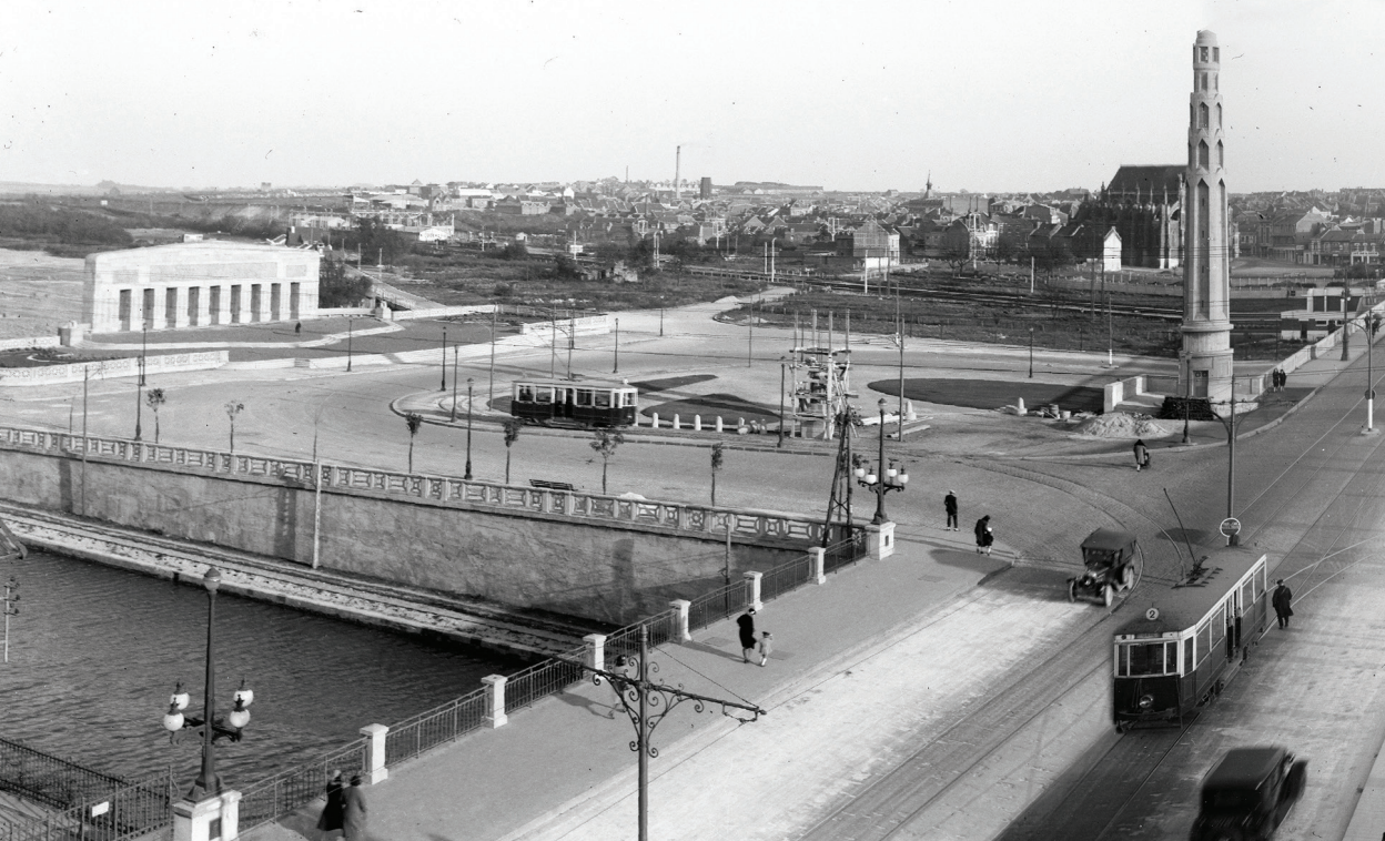
Le parvis de la gare en 1932. Montage panoramique réalisé à partir de deux photographies.
