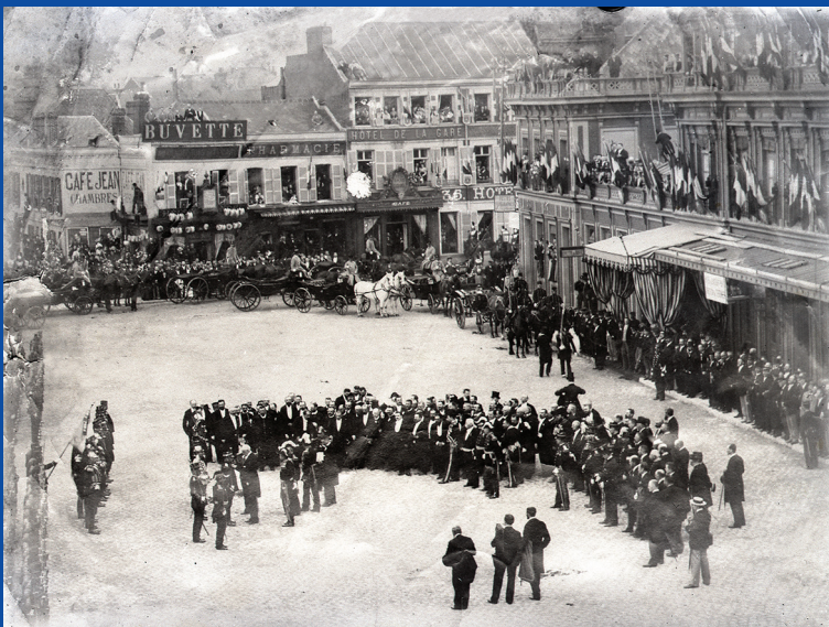
Place de la Gare et angle de la rue de la Raffinerie et de la route de Laon. Photographie prise lors de la réception en gare de Saint-Quentin du Président de la République Félix Faure, en juin 1897.
