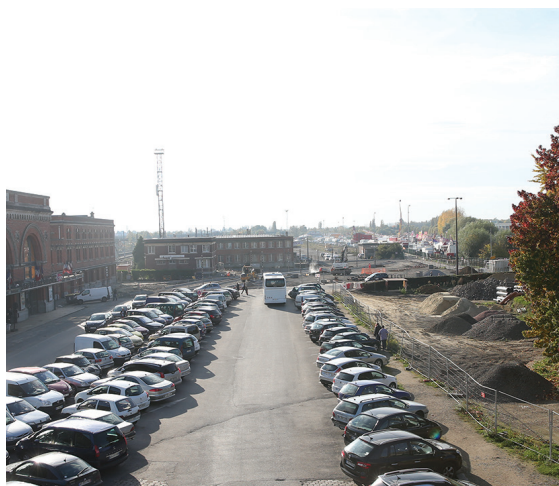
Après la période des fouilles, une partie du parvis est livrée à nouveau au stationnement, tandis que l'extrémité ouest du site est en cours de travaux, octobre 2015.
