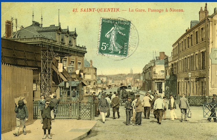
Passage à niveau de la route de Laon, photographié en direction du centre-ville vers 1900. On distingue à gauche le pavillon est de la gare, et la passerelle métallique aménagée en 1884 pour faciliter la traversée des piétons. Carte postale.
