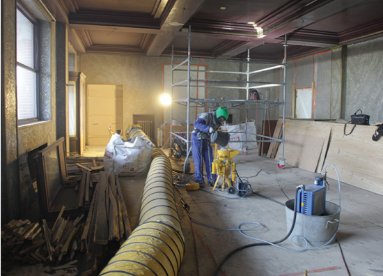
Opérations de sablage, décembre 2016.
