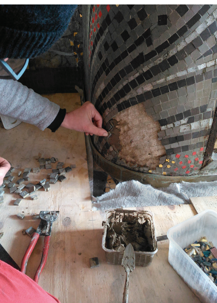
Restauration de la mosaïque de l'une des dessertes de la salle du buffet, avril 2017.
