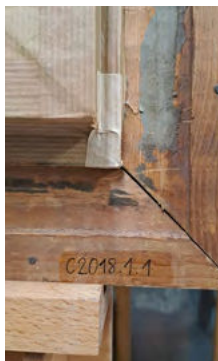
Marquage cadre ancien réalisé à l'encre de Chine
